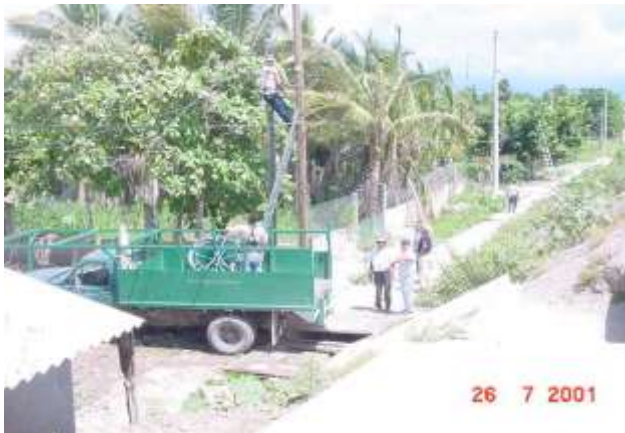
Distrito EZC 4/1, montaje de 120 Postes, Tendido y conexión de 8km de cable en desde 10 Ps hasta 300 Ps Mezcales, Nayarit
