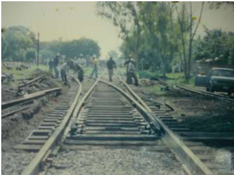
Construcción de Terracerías y Cambio de Durmiente y Tendido de Vías en patio de Ocotlán, Jalisco
